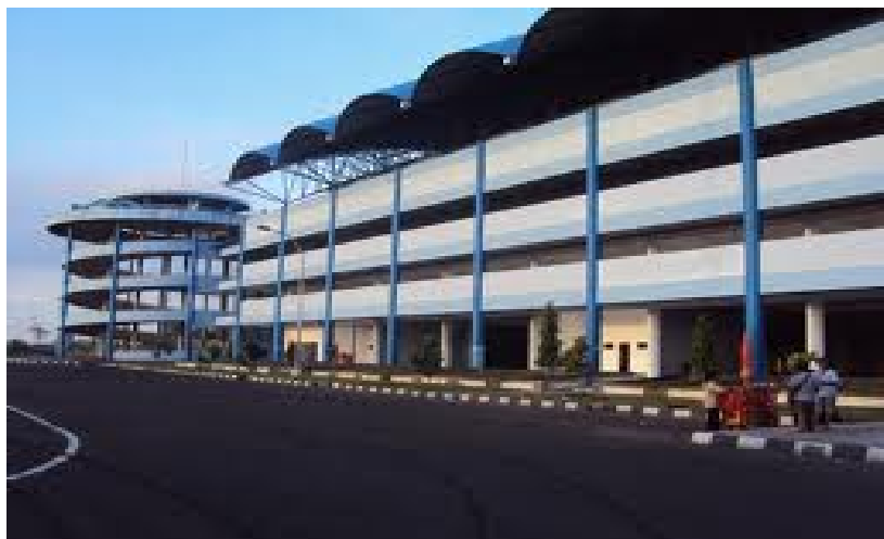
Gambar 1. Bangunan Sayap Timur Stadion Maguwoharjo
