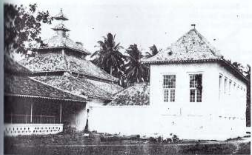
Gb. 8: Masjid Banten. Sebelah kiri nampak bangunan berlanggam Belanda.
