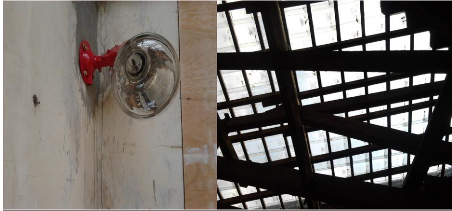
Gambar 19. Sebelah kiri : Lampu infra merah dengan daya 500 watt untuk pemanas ruangan
