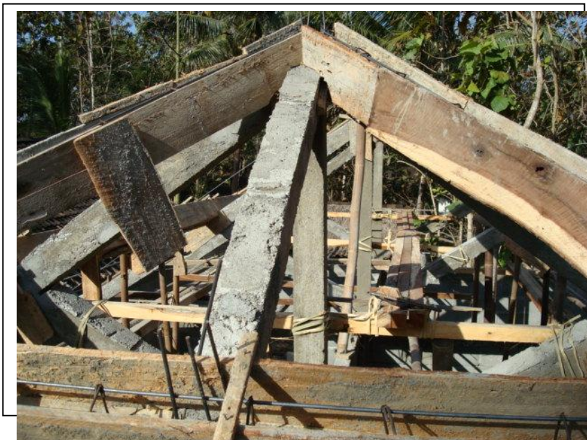
Gambar 13. Contoh Konstruksi Rangka Atap Beton Tahan Gempa
