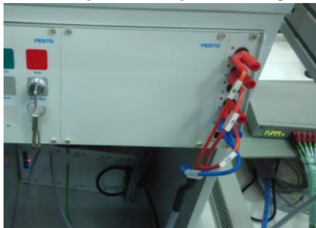
Gambar 3. Jumper dari Konveyor Sistem
