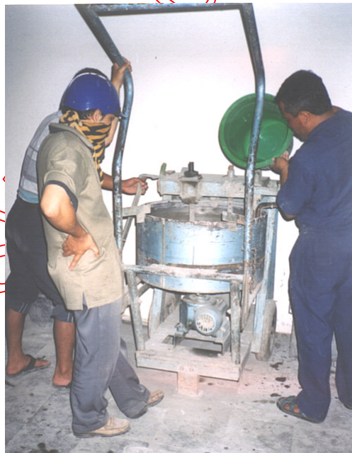
Gambar 2. Pelaksanaan Pencampuran Adukan Beton
