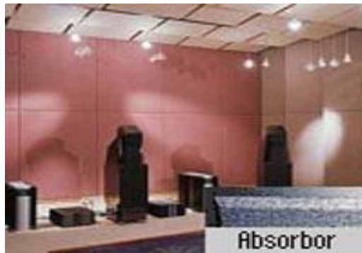
Gambar 14. Penerapan Panel Penyerap pada plafond dan dinding Sumber: http://www.acoustics.com/product
