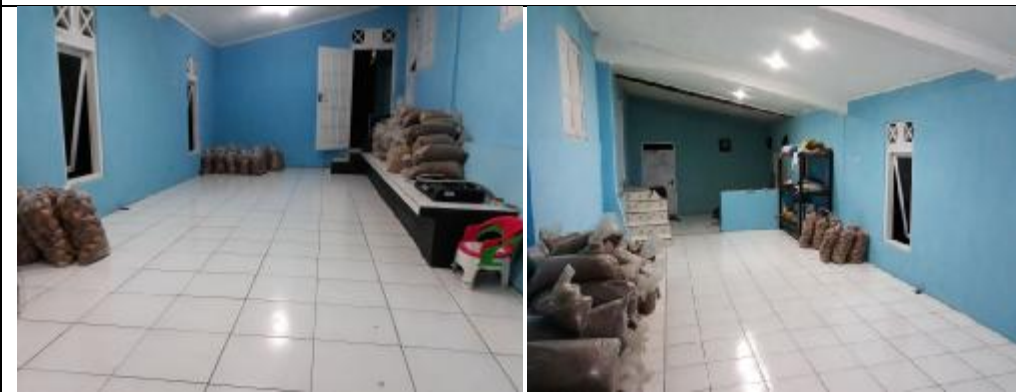
Kondisi setelah direhab
